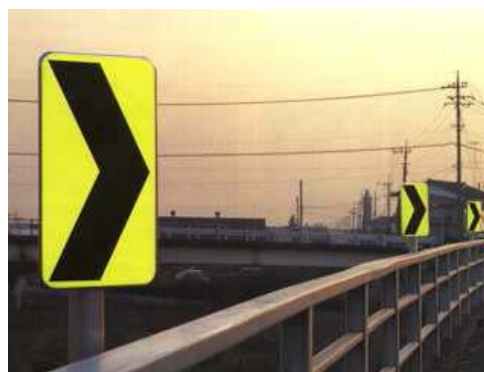
蛍光反射標識（視線誘導標）
