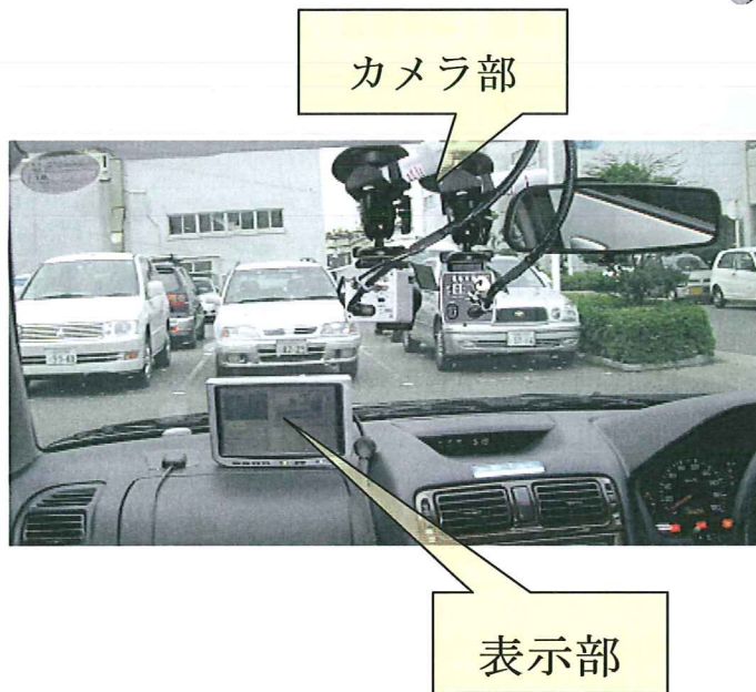
図 4-15 システム構成概要及び車内設置状況
